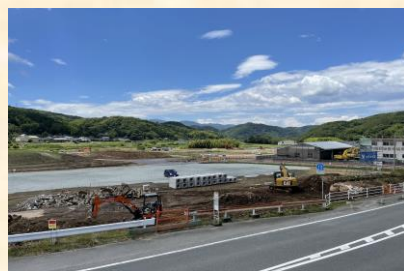
中伊豆温泉病院 工事現場
