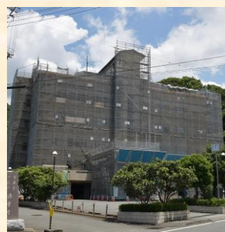
土肥支所庁舎改修工事
