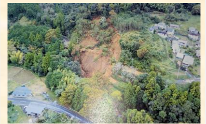
市道月ヶ瀬吉奈線崩落
