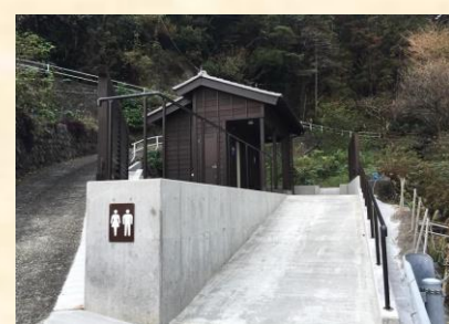
新設された米崎の公衆トイレ
