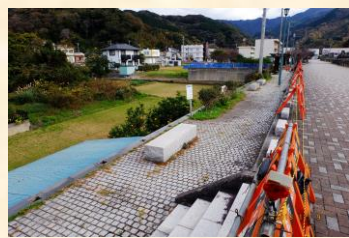
土肥山川ポケットパーク改修工事
