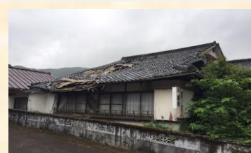
放置されたままの元旅館
