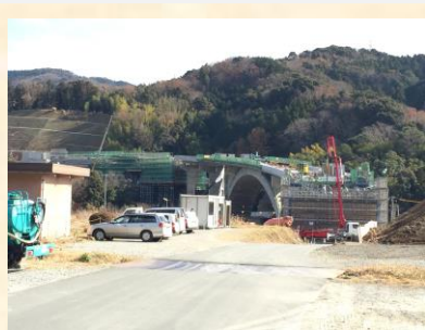
インターチェンジ付近の工事現場
