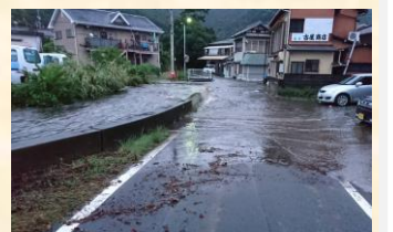
八木沢西浜地区冠水被害
