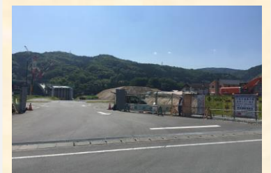
月ヶ瀬道の駅建設予定地
