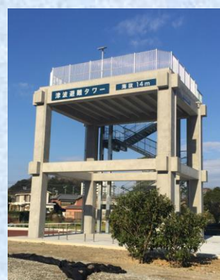
八木沢津波避難タワー
