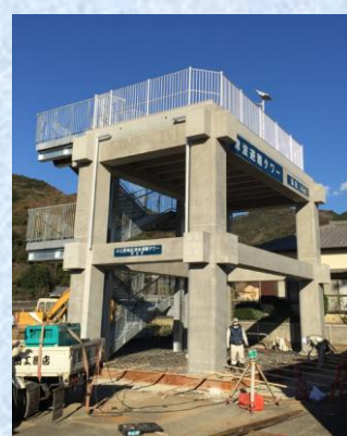
小土肥津波避難タワー
