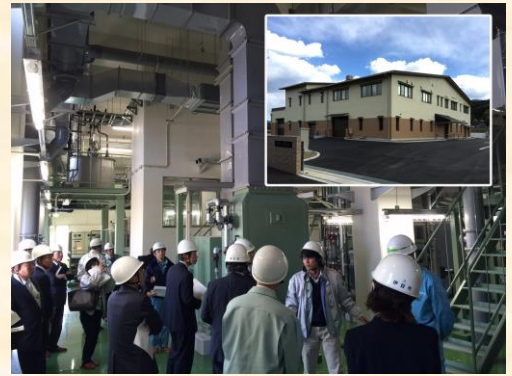
汚泥再生処理センター“ピュア・プラザ”
