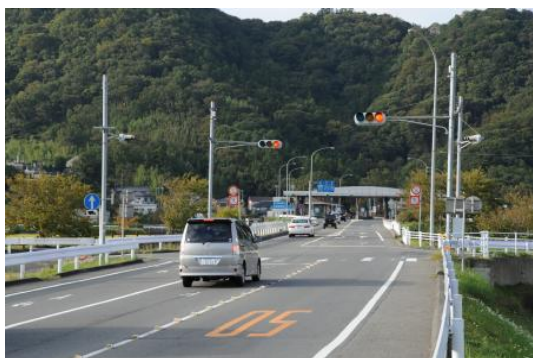
現在の江間交差点を立体化してフルインターチェンジ化 写真奥の自動料金所も有人料金所として回数券で対応予定
