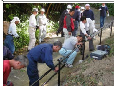
土肥小学校裏山避難路整備
