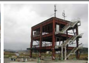
旧南三陸防災対策庁舎
